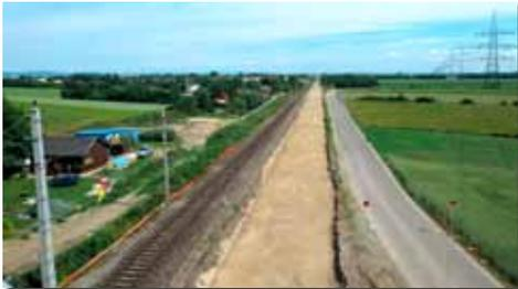
Auch im Norden von Münchendorf ist die Trasse für das zweite Gleis fertig. Weiters sind die Stützen für die Lärmschutzwand schon vorbereitet.
