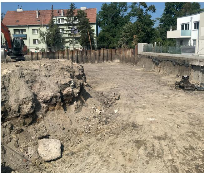
Nach den Rammarbeiten für die Spundwände wurde sofort mit dem Aushub für die Tiefgarage begonnen.
